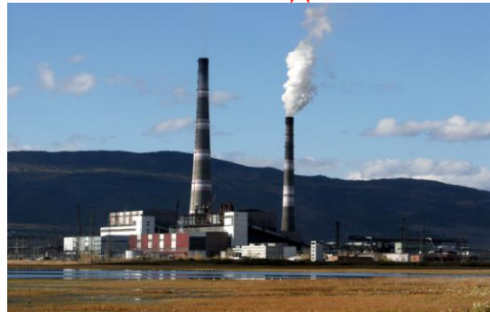
Гусиноозерская ГРЭС ТГ №4 – 210 МВт
